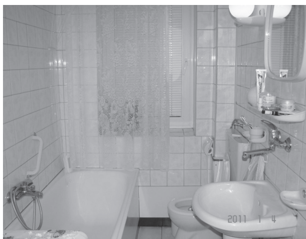
Ryc. 1. i 2. Widok łazienki przed adaptacją
